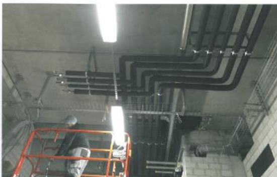
Leitungsmontage während des Umbaus; das Projekt musste im laufenden Metzgereibetrieb und unter strikter Einhaltung der Hygienevorschriften umgesetzt werden.
