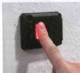
Sicherheit wird groß geschrieben: Der Zugang zum Serverraum ist nur nach Fingerabdruckscan möglich
